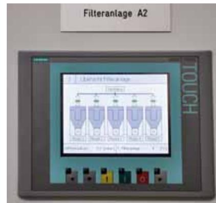
**Bild 5:** Die Bedienung und Visualisierung der Filteranlagen erfolgt über Touch Panels.
