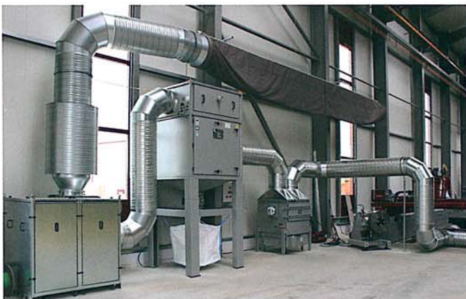
Die Absaug- und Filteranlage „ZPF“ nimmt die schadstoffhaltige Luft auf und reinigt sie.
